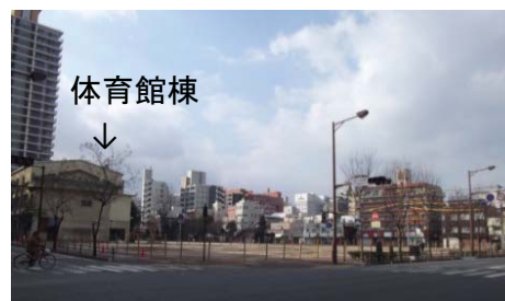
現況(体育館棟を残し解体済)
