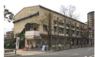
既存体育館(H28.11撮影)
