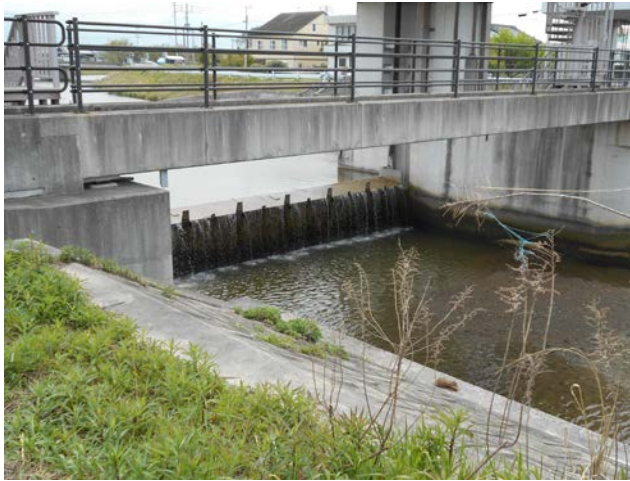
図8 昭代橋上流の堰
