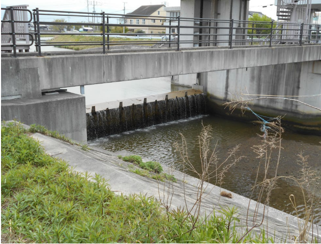
図2 昭代橋上流の堰
