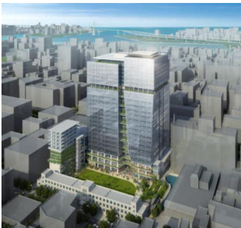
南東上空よりの全景
