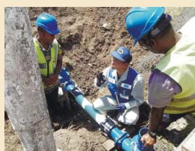
現地での水道管の施工指導の様子です。現地では、正しい方法で工事が行われていないことも、漏水の原因のひとつとなっています。
