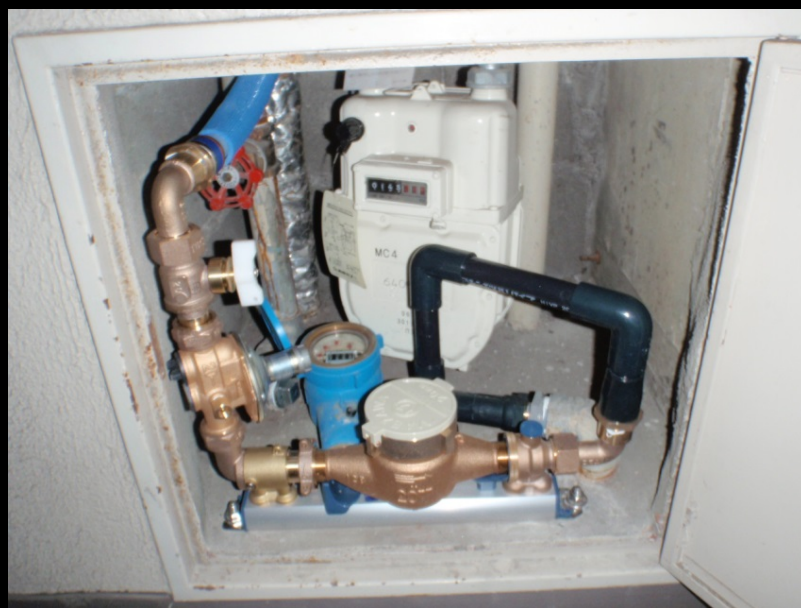
狭いパイプスペース
