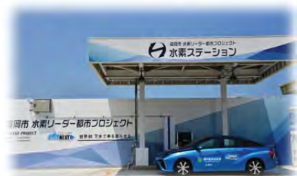
下水バイオガス水素ステーション
