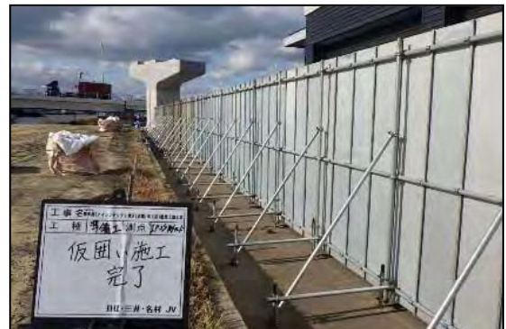
写真④-4 防音パネル等の遮音対策
