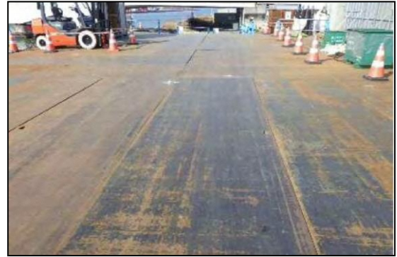
写真④-2 敷鉄板の設置による防塵対策
