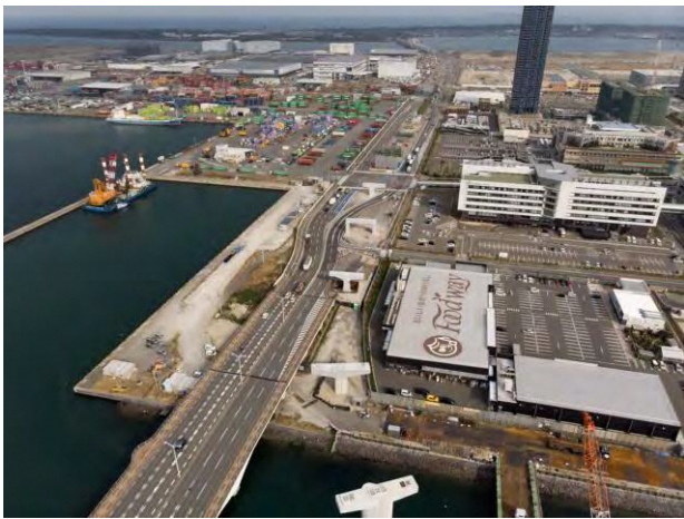
工事進捗状況写真（平成 31 年 3 月）
