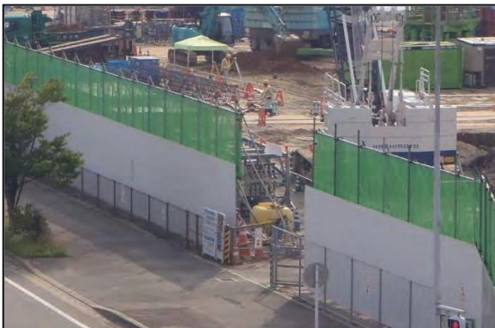
写真③-3 防音パネル等の遮音対策
