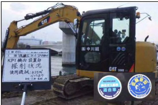
写真④-5 低騒音型建設機械の使用状況 (1)
