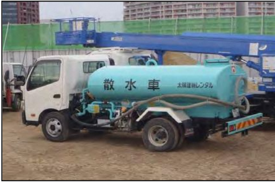
写真③-1 施工ヤードへの散水設備
