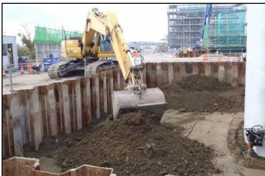
写真③-7 発生土による埋戻し
