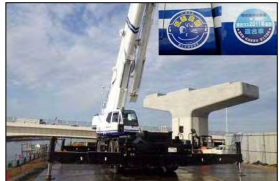
写真④-6 低騒音型建設機械の使用状況 (2)
