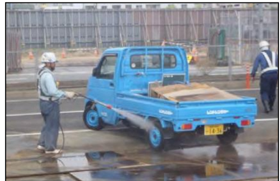
写真①-6 工事用車両のタイヤ洗浄状況
