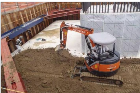
写真②-7 発生土による埋戻し
