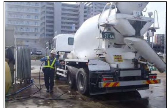
写真②-6 工事用車両のタイヤ洗浄状況
