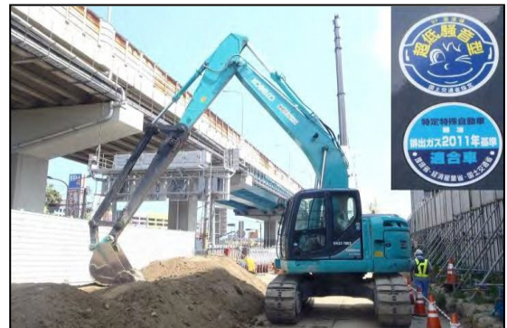
写真①-4 低騒音型建設機械の使用状況
