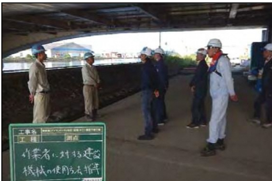
写真④-3 建設機械の取り扱いの指導状況
