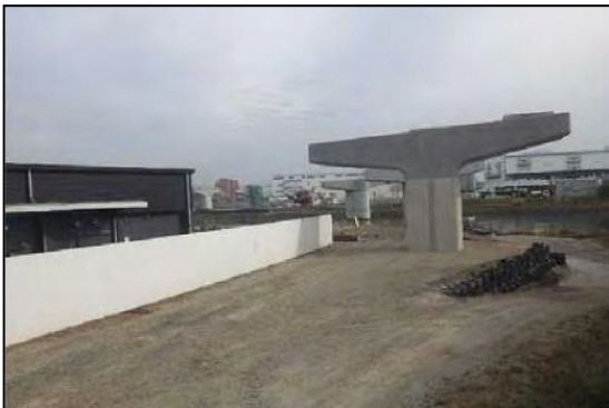
写真⑤-3 防音パネル等の遮音対策
