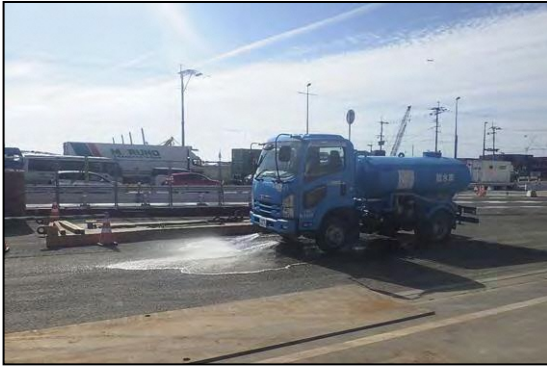
写真⑤-1 施工ヤードへの散水状況
