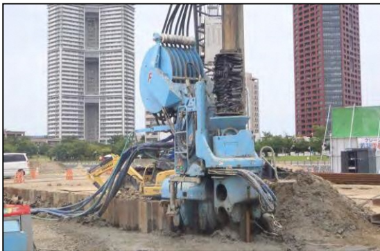
写真③-5 低振動工法の採用 (鋼矢板打設の圧入工法)
