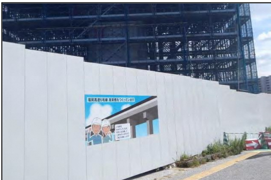
写真②-3 防音パネル等の遮音対策
