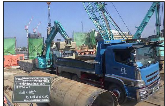
写真⑤-6 発生土の仮置き場への運搬状況
