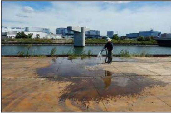
写真④-1 施工ヤードへの散水
