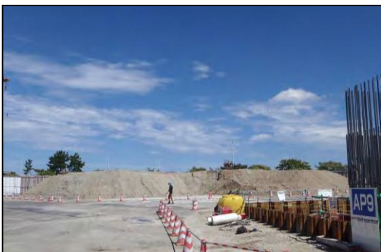
写真①-7 発生土の仮置き
