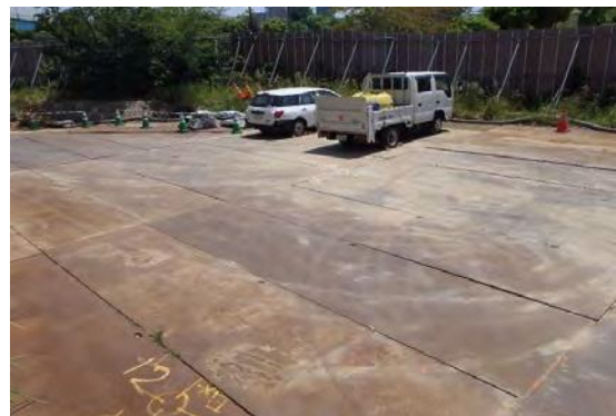
写真①-6 敷鉄板の設置による粉じん対策
