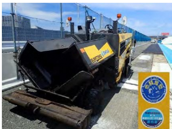
写真⑥-3 低騒音型建設機械の使用状況 1
