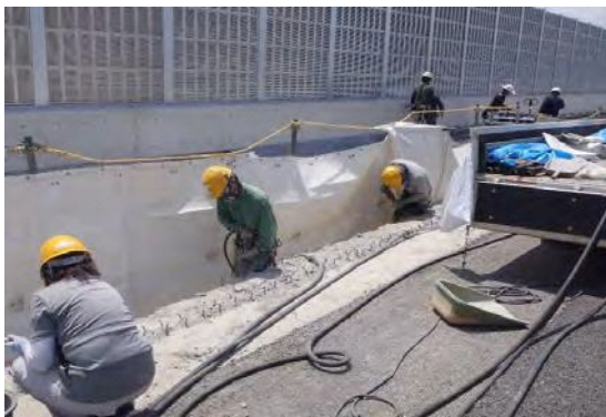
写真①-3 防音シートの設置による遮音対策
