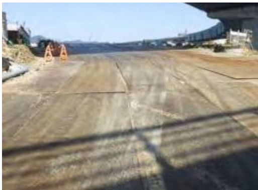
写真④-5 敷鉄板の設置による粉じん対策
