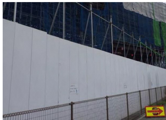
写真③-4 防音パネルの設置による遮音対策
