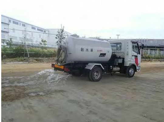
写真③-1 施工ヤードの散水状況
