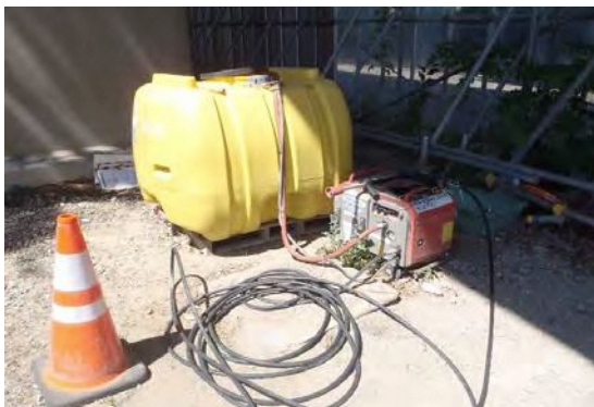
写真①-7 工事用車両のタイヤ洗浄設備
