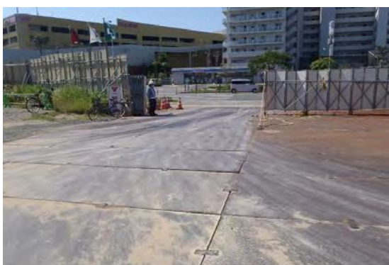
写真②-5 敷鉄板の設置による粉じん対策
