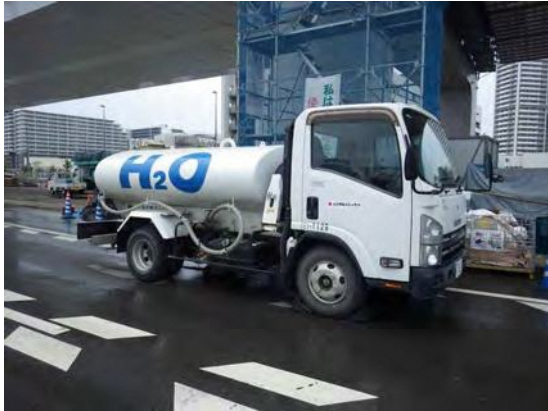
写真⑤-1 施工ヤードの散水設備
