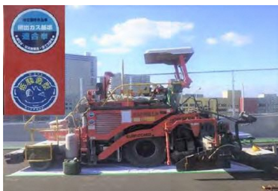
写真⑥-4 低騒音型建設機械の使用状況 2
