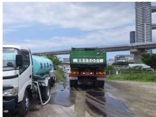
写真③-6 工事用車両のタイヤ洗浄設備
