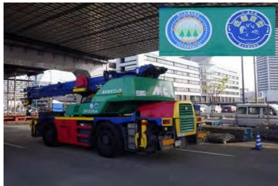
写真⑤-4 低騒音型建設機械の使用状況 2
