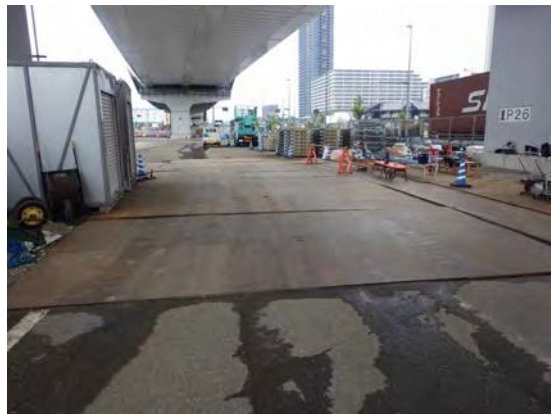
写真⑤-6 敷鉄板の設置による粉じん対策
