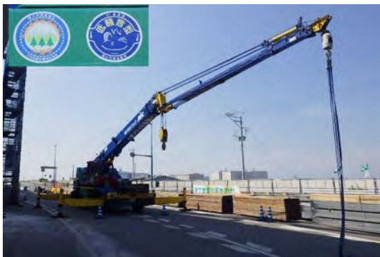
写真⑤-3 低騒音型建設機械の使用状況 1
