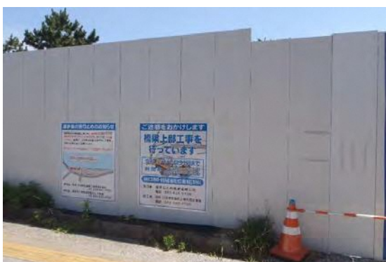
写真②-3 防音パネルの設置による遮音対策
