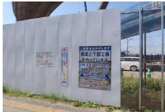
写真①-4 防音パネルの設置による遮音対策
