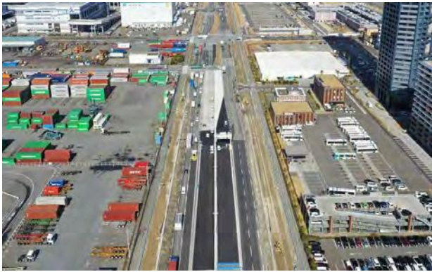
工事進捗状況写真（令和3年2月）
