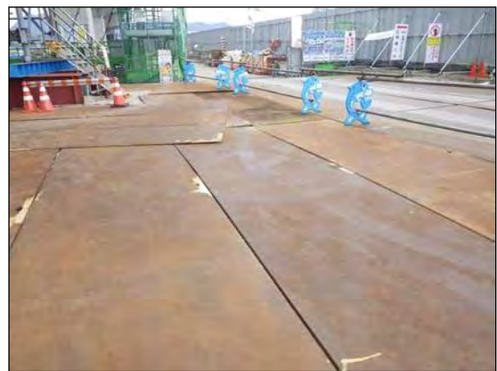
写真④-6 敷鉄板の設置による 粉じん対策状況
