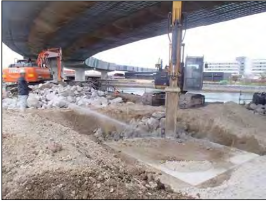
写真④-1 施工ヤードへの散水
