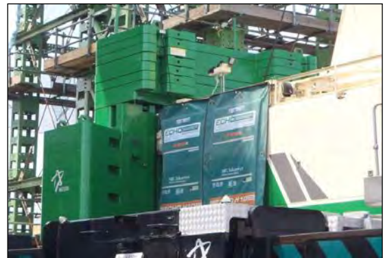
写真②-4 エンジン部の防音シートの設置
