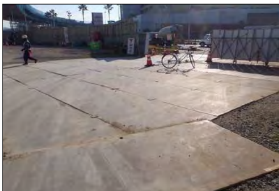
写真②-7 敷鉄板の設置による粉じん対策
