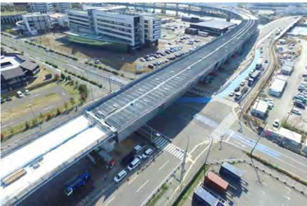
工事進捗状況写真（令和2年3月）
