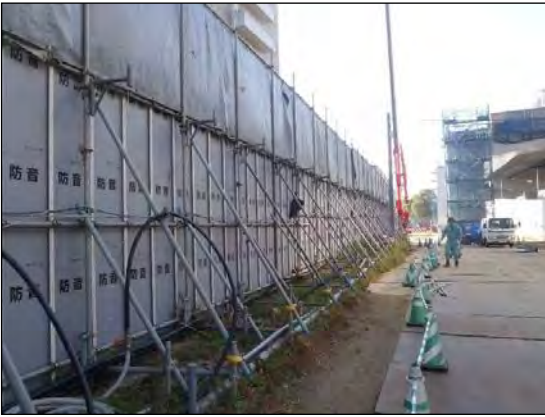
写真①-3 防音パネルの設置
