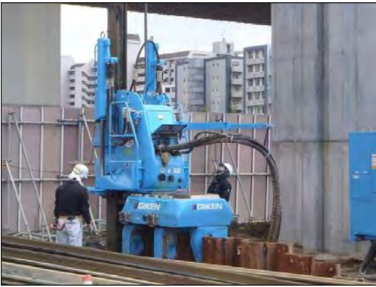
写真①-5 低振動工法の採用
