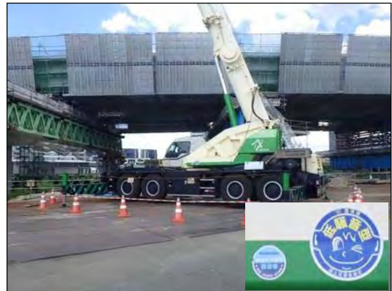
写真④-4 低騒音型建設機械の使用状況 (1)
