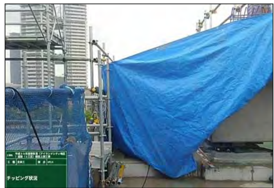
写真③-4 沓座チッピング作業時の粉じん対策（外側）
