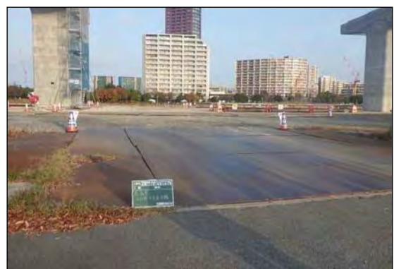
写真③-8 敷鉄板の設置による粉じん対策
