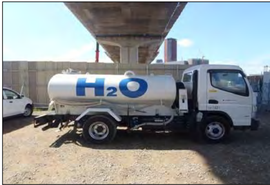
写真②-1 施工ヤードへの散水設備
