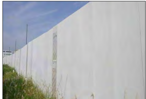
写真③-6 防音パネルの設置
