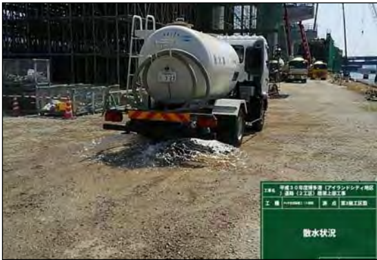
写真③-1 施工ヤードへの散水状況
