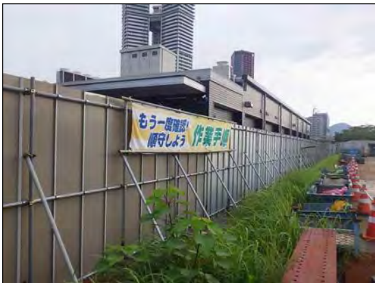
写真④-3 防音パネル等の遮音対策
