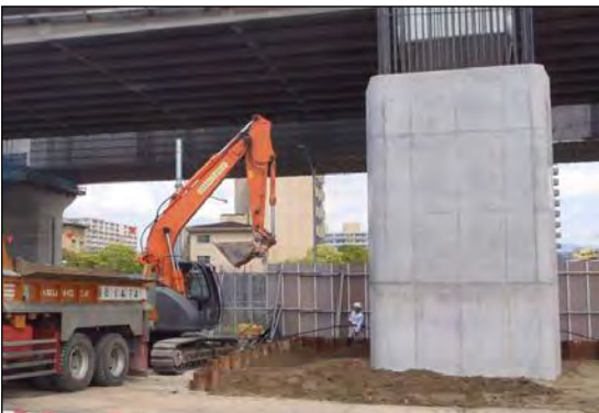
写真①-7 発生土での埋戻し
