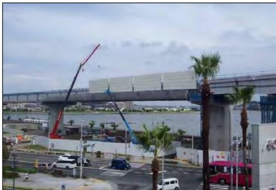
写真②-3 防音用落下防護棚の設置
