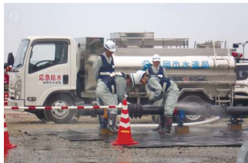
防災訓練での水道管の復旧の様子
