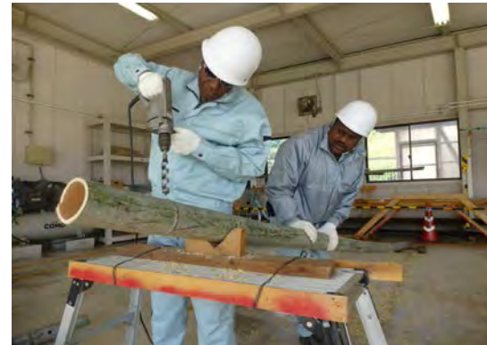
竹を利用した 浸出水の集排水管作成
