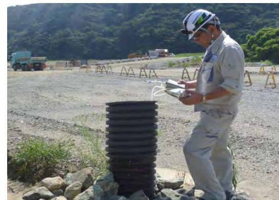
埋立場のガスのサンプリング調査
