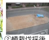
②植栽伐採後 整地完了
