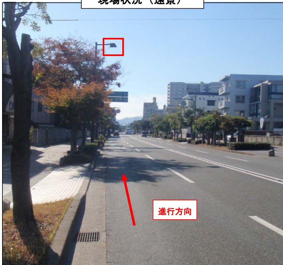
現場状況（遠景）
