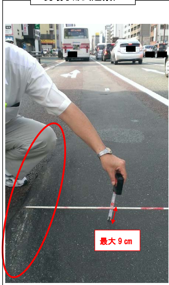
現場状況(近景)
