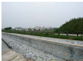
<生きものの生息に配慮した護岸整備>
