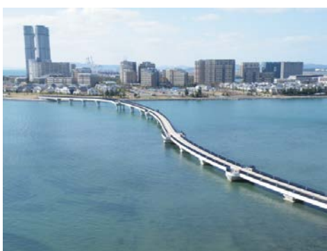
<海上遊歩道(あいたか橋)>
