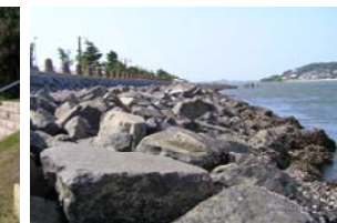
＜生きものの生息に配慮した護岸＞
