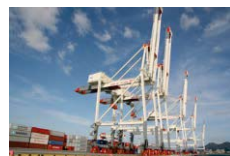
ガントリークレーン
