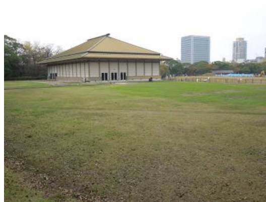
鴻臚館跡展示館の外観
