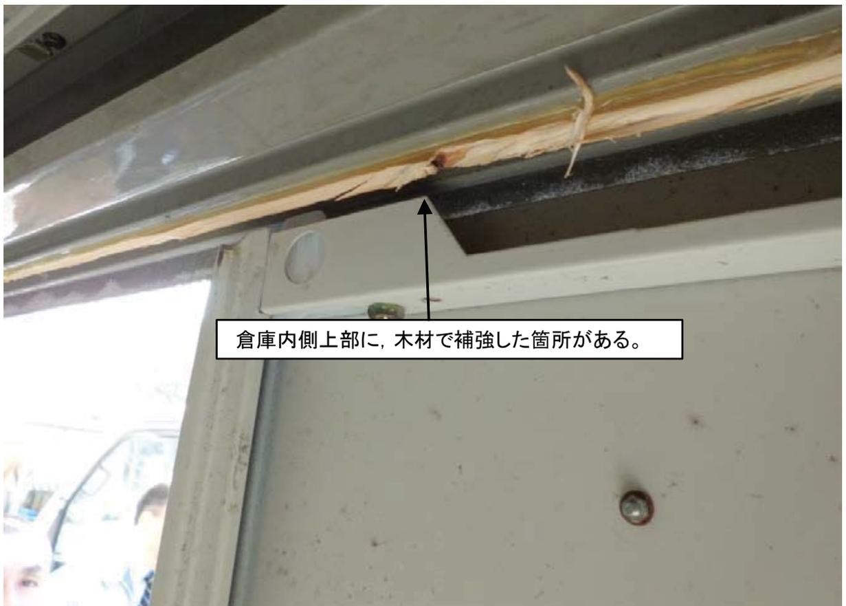
倉庫内側上部に、木材で補強した箇所がある。
