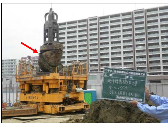
○クレーンによる撤去作業
