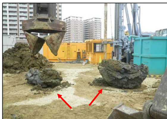
○砕いて撤去した地中支障物の一部
