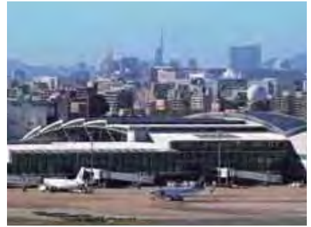
▲福岡空港国際線ターミナル
