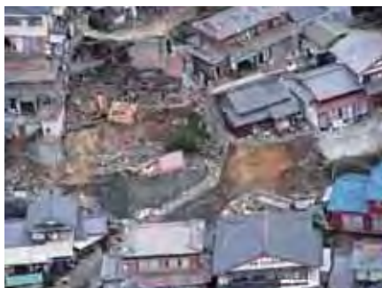
▲福岡県西方沖地震による被害(玄界島)
