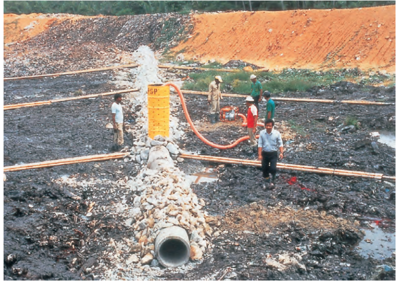
竹や廃ドラム缶を使った循環式準好気性埋立地
