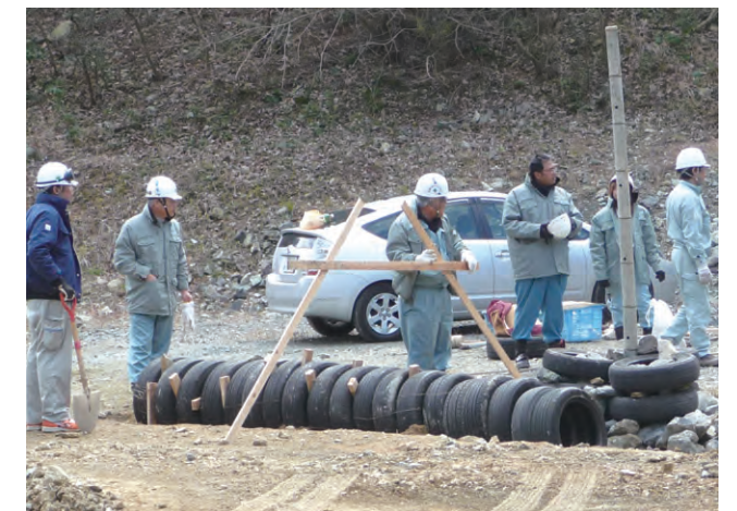
廃タイヤを利用した浸出水集排水管の施工実習
