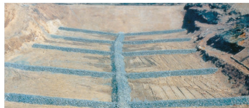
日本における最初の準好気性埋立場(新蒲田埋立場)(1975年)
