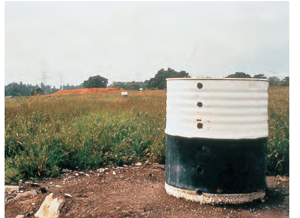
ガス抜き設備の効果により、植生が回復
