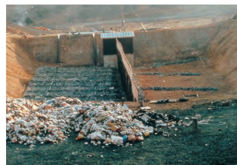
久山埋立場における現場実験(1974年) 〈左側…好気性埋立、右側…準好気性埋立〉
