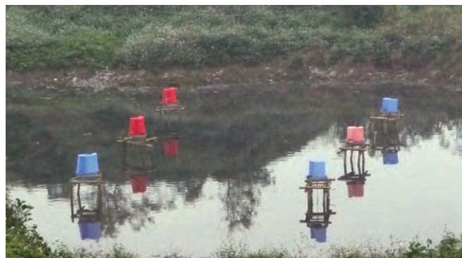
浸出水調整池 ECO-FAN※完成(2012年) ※風力を利用し廃材等で作った調整池攪拌装置
