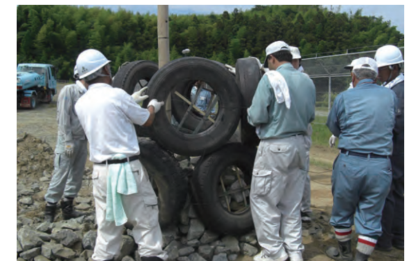
廃タイヤを利用した堅型ガス抜き施設の施工実習(2008年)
