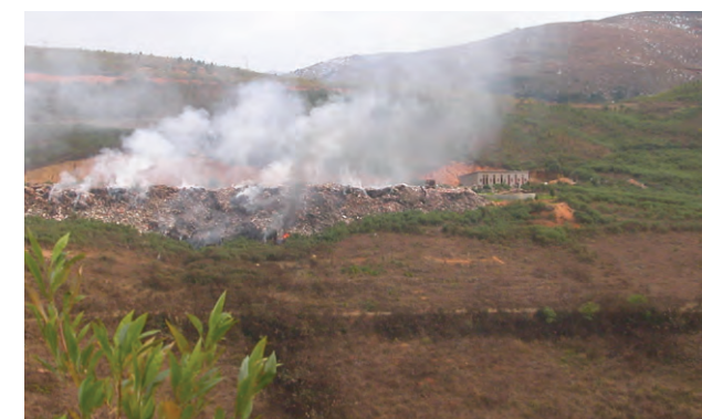
整備前の埋立地の状況(ごみが自然発火している)(2003年)
