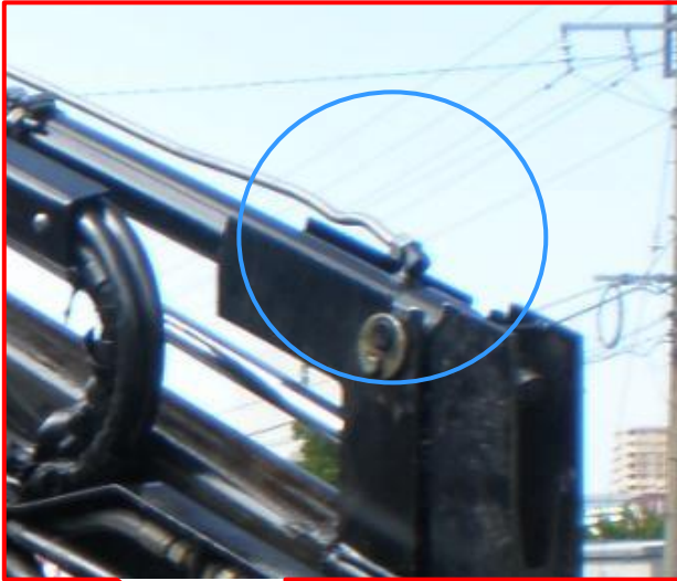
破損したオイルパイプの先端
