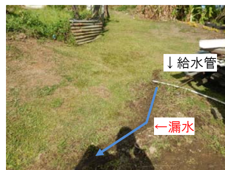
家庭への給水管からの漏水
