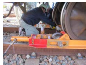
保守係員脱線復旧訓練
