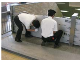
止水板設置訓練
