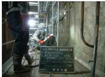
土木構造物改良工事
