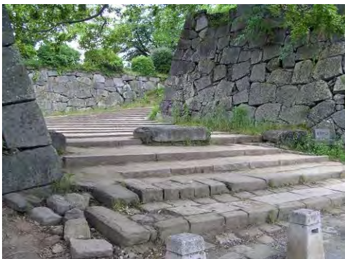
写真 2-63: [15] 東御門跡を見る 石垣及び城郭特有の鍵型の道を見ることができる。
