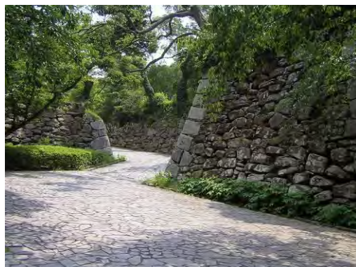
写真 2-67: [19]桐木坂を見る 石垣と鍵型の出入口の構成を見ることができる。
