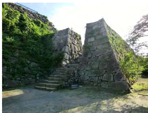
写真 2-80: 32 鉄御門跡を見る 石垣と石垣に挟まれた天守台へと繋がる往時の道を見ることができる。
