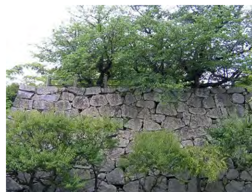
写真 2-76: 28 時櫓跡石垣を見る 特徴的な石垣の景を間近で見ることができるが、手前に生育する樹木が視線を遮蔽している。
