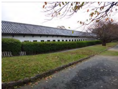
写真 4-9：樹木整理前の多間櫓
