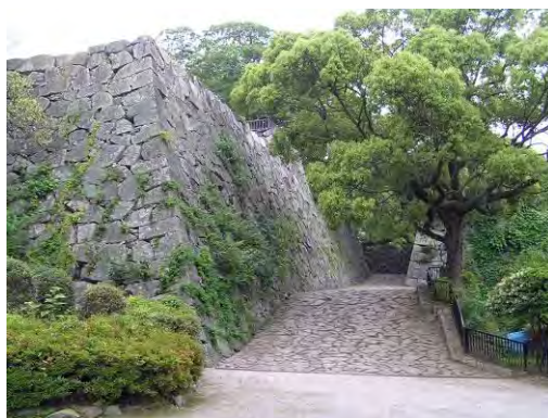
写真 2-74: 26 本丸裏御門より武具櫓御門方向を見る 本丸へと繋がる道と道沿いの石垣を一体的に見ることができる。
