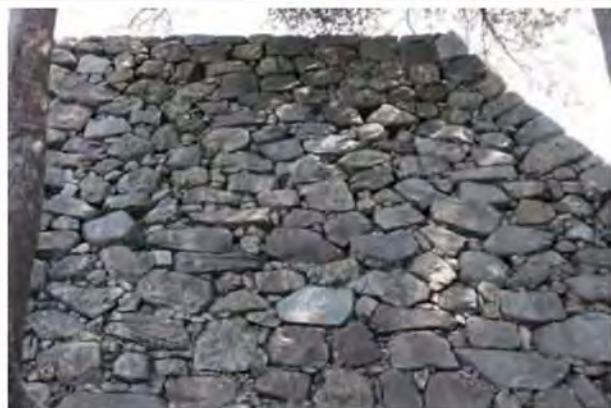
写真2-17:A類(天守台)
