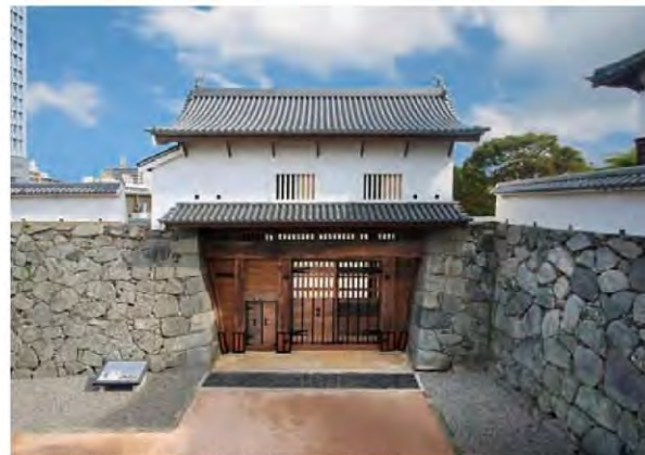
写真2-10: 下之橋御門 (県指定有形文化財)
