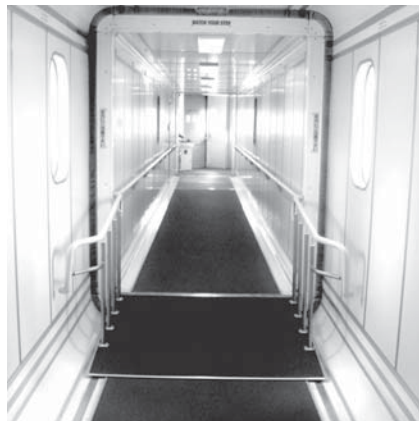
搭乗橋内部の例
