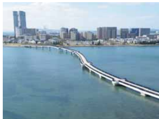
<海上遊歩道(あいたか橋)>
