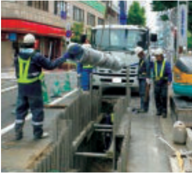
水道管の工事の様子
