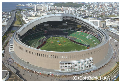
雨水を利用している福岡PayPayドーム
