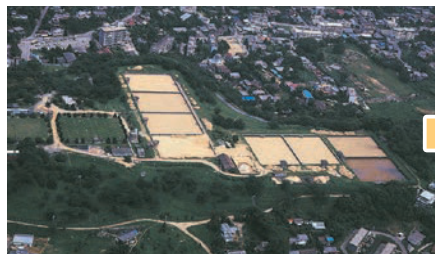
○福岡市ではじめてつくられた浄水場(平尾浄水場)
