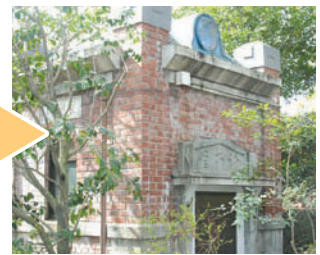
○現在、植物園に残っている平尾浄水場の建物の一部(配水池の点検用入口)
