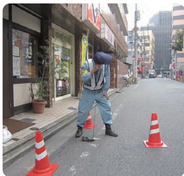
地下で水もれがないかどうか、音を聞いて調べています。
