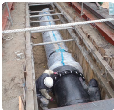
水もれがおきないように、古くなった配水管を計画的にとりかえています。
