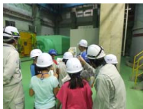
②蒸気タービン室
