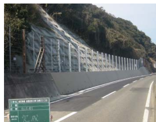
写真2 整備後の法面の例
