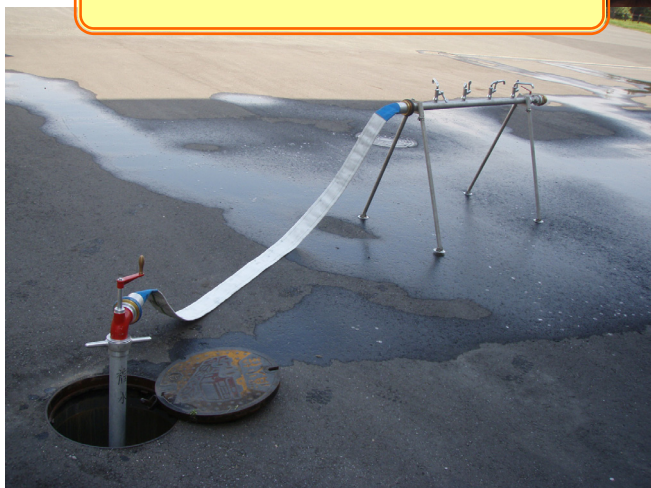
消火栓に応急給水栓を設置した様子
