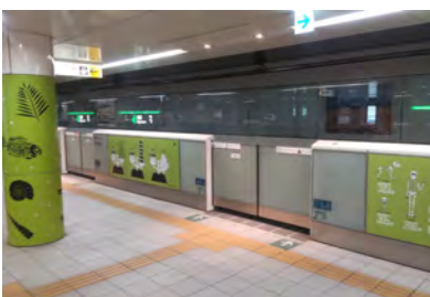
■写真4 ホームドア、視覚障がい者誘導用ブロックの設置(転落防止)
