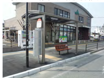
■写真 18 標準的な設置例(歩道)
