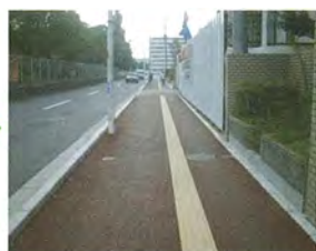
■写真8 歩道の整備 (歩道拡幅、誘導ブロックの設置)
