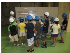
③蒸気タービン室
