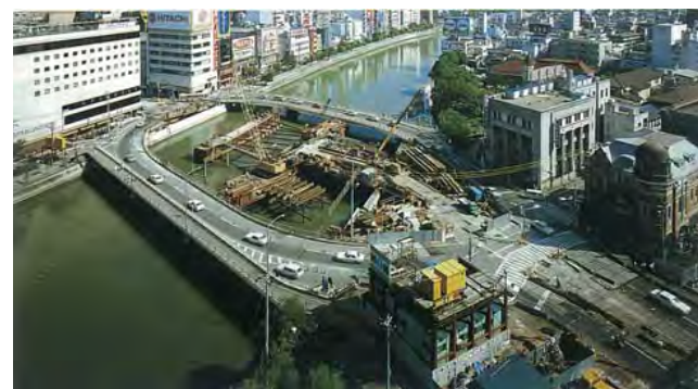
⑤地下鉄工事と西大橋の整備
