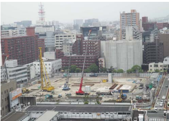
敷地全景（北側から撮影）
