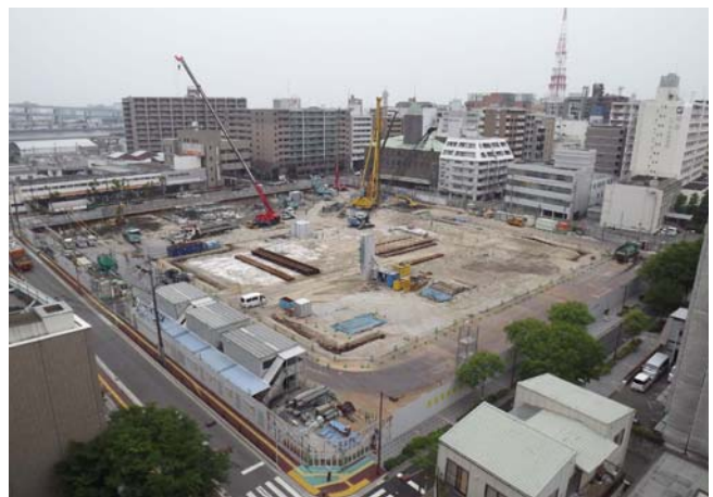
敷地全景（南西側から撮影）
