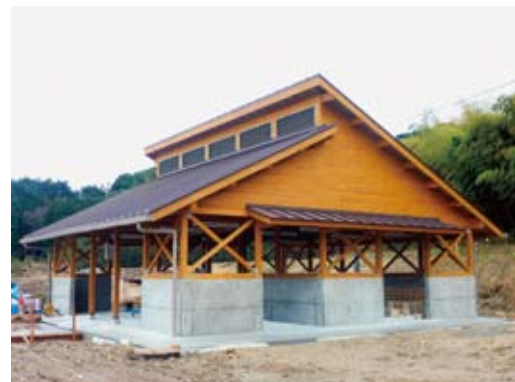
地域産材を利用した公共建築物
