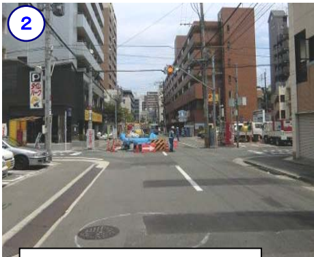
横断歩道の新設
