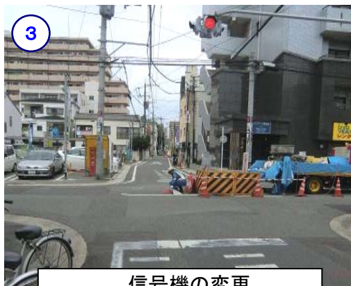
信号機の変更 (点滅式→押しボタン式)
