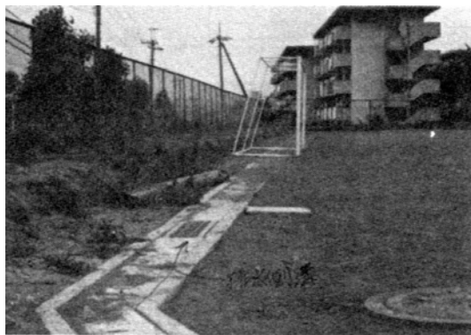
写真. 排水側溝
