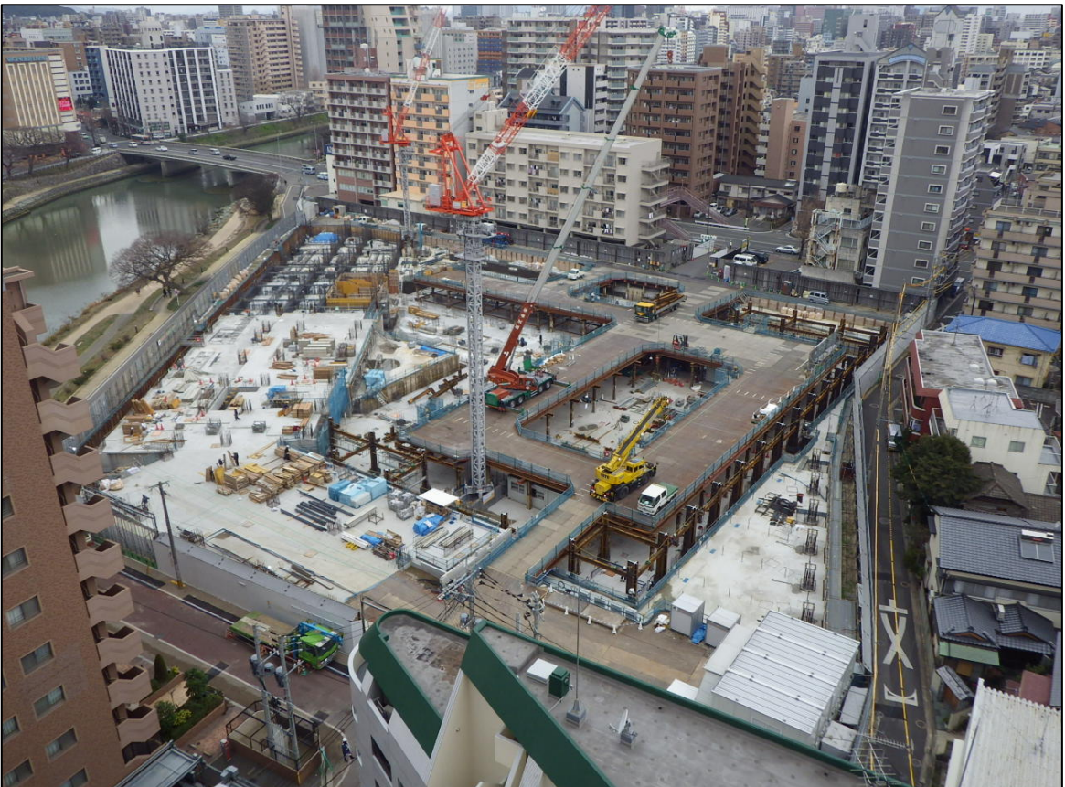
敷地全景（南側から撮影・1月末時点）
