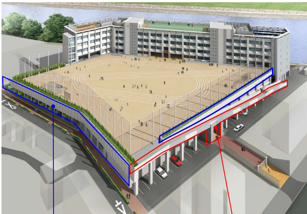
北東方向からの外観
