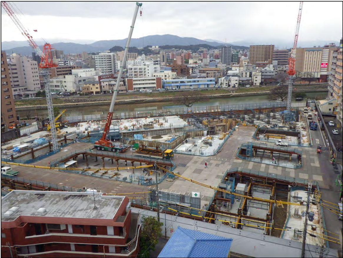
敷地全景（東側から撮影・1月末時点）
