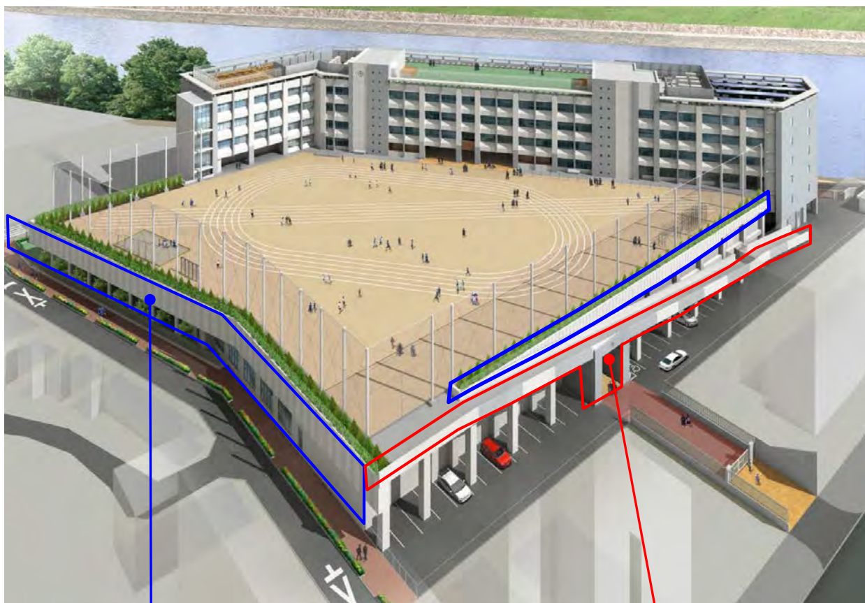
北東方向からの外観
