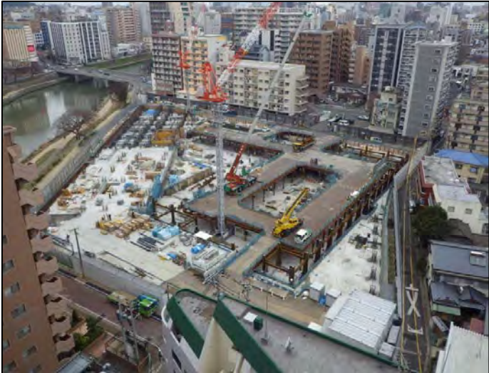
敷地全景（南側から撮影・1月末時点）
