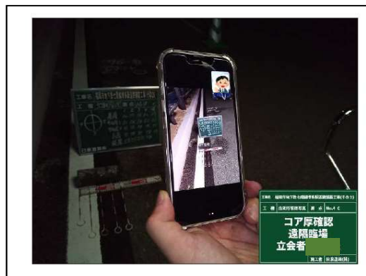
【立会状況（現場側）全体】
