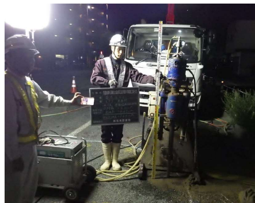
【立会状況②（現場側）】
