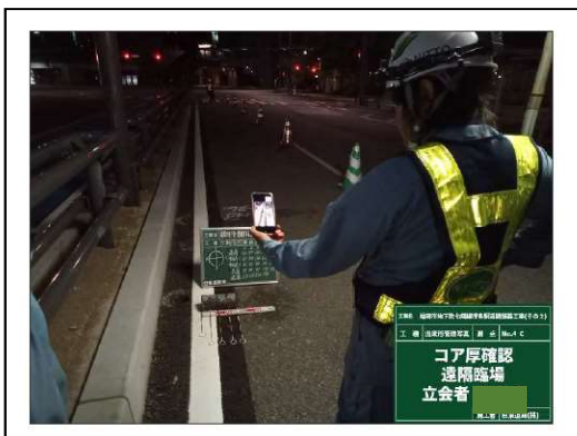
【立会状況（現場側）全体】
