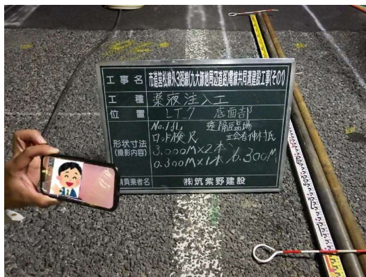
【立会状況②（現場側）】
