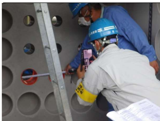
【立会状況①（現場側）】
