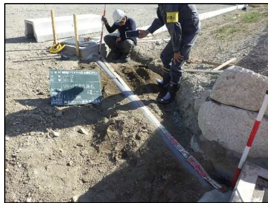
【立会状況②（現場側）】
