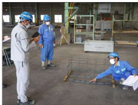
【立会状況②（現場側）】
