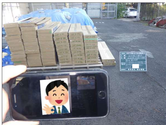
【立会状況①（現場側）】
