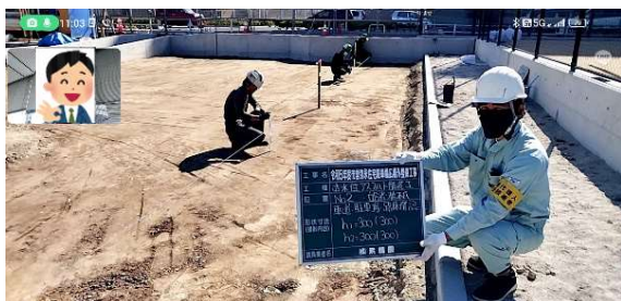
【立会状況① (現場側)】
