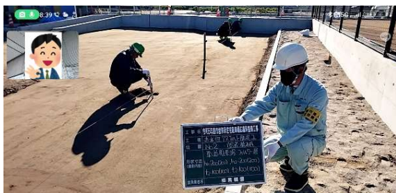
【立会状況③ (現場側)】
