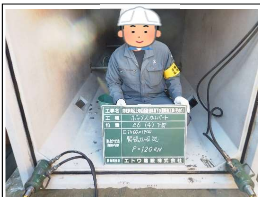
【立会状況①（現場側）】
