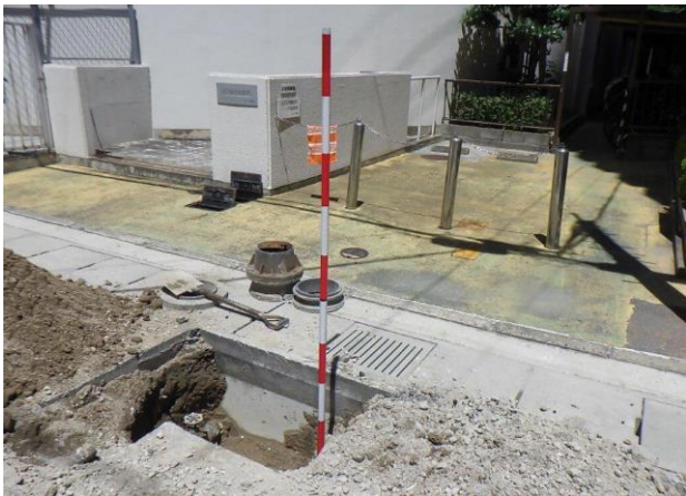
地下埋設物の埋設箇所に目印を設置し、埋設物の有無を可視化
