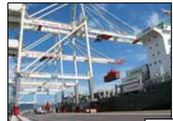
풀가동 중인 갠트리 크레인
