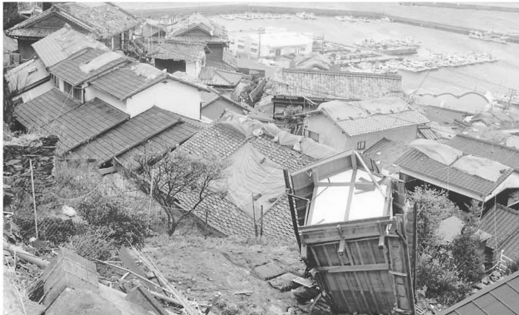
地震で損傷した屋根をビニールシートで覆った玄界島の家庭
