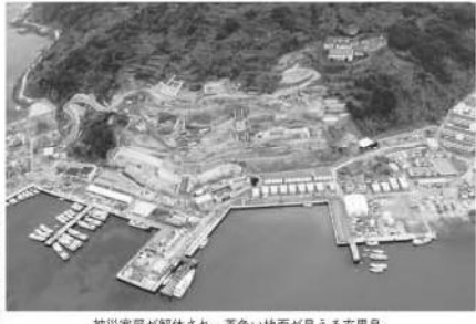
被災家屋が解体され、茶色い地面が見える玄界島。(今年2月撮影) 着々と造成工事を進めている
